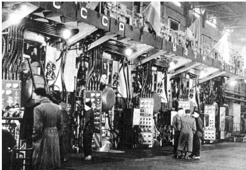
Walcownia Zimnych Blach – walcarka 5-cio klatkowa
