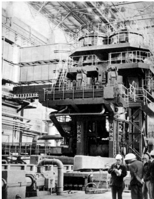
Klatka walcownicza Walcowni Slabing
