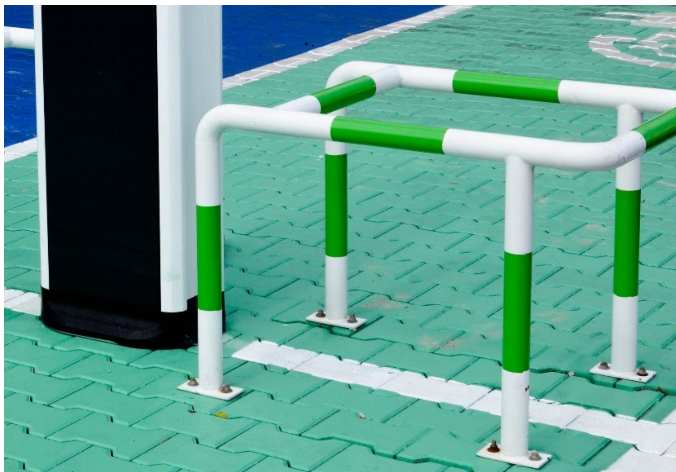
Zdjęcie 9. Przykładowe zabezpieczenie fizyczne w postaci barierki
